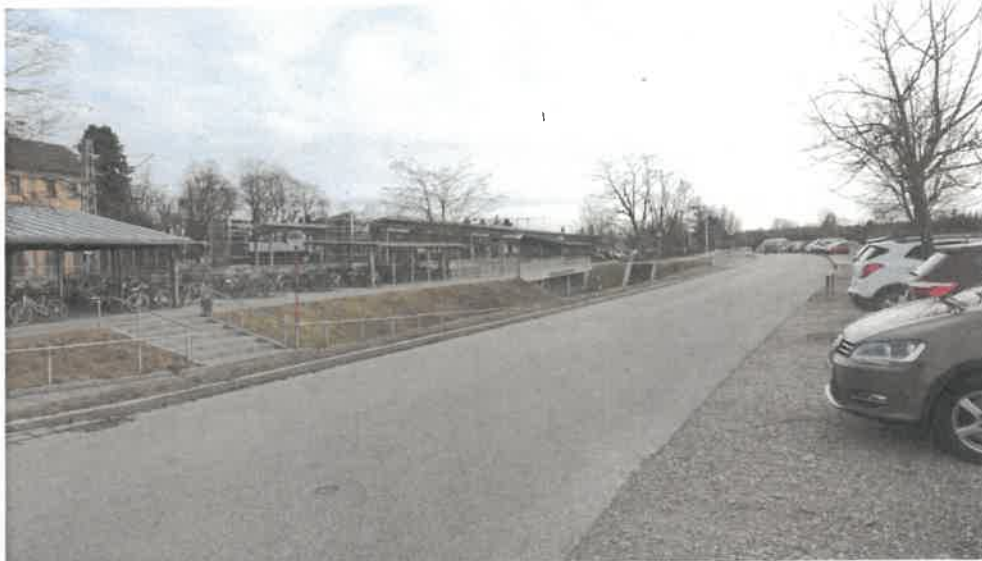
Bahnhof, Sauerlacher Straße, Blick nach Süden
