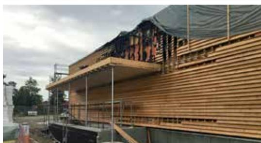
noch während der Sommerferien wurden Teile der Wandpaneele abgenommen, um die tragende Holzkonstruktion und die Dämmung dahinter auf Löschwasserschäden untersuchen zu können. Dies galt auch für den Bodenaufbau, der zurückgebaut werden musste, um Brandrückstände feststellen zu können.
