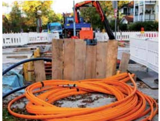
Die Voraussetzungen für den Bau des Glasfasernetzes werden bereits geschaffen: Zusammen mit den Fernwärmerohren werden Leerrohre für die Datenleitungen verlegt.
