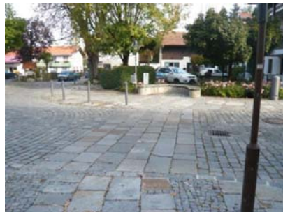
Struktur im Straßenbelag
